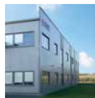
Gewerbe- und Industriebau
